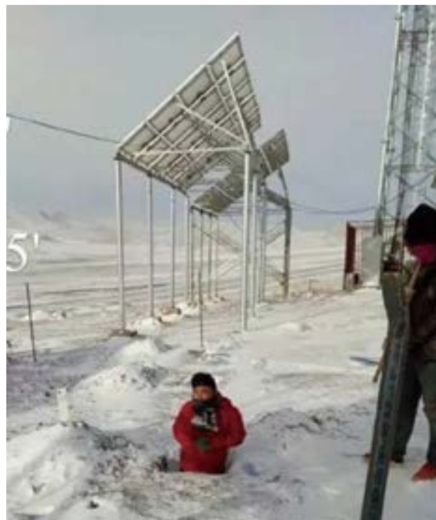
在海拔4000多米的移动基站开展维护工作
