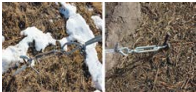
简陋的地角扣存在安全隐患
