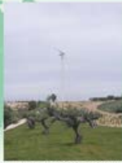
100kW Wind power + 25kW PV 自发自用项目
