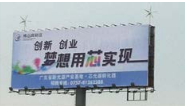
高速公路广告牌供电系统
