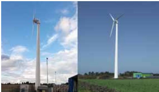
图 13: 100kW 独立运行机组分别安装于英国和韩国的分布式微网系统, 运行一年发电量近 14 万千瓦时
