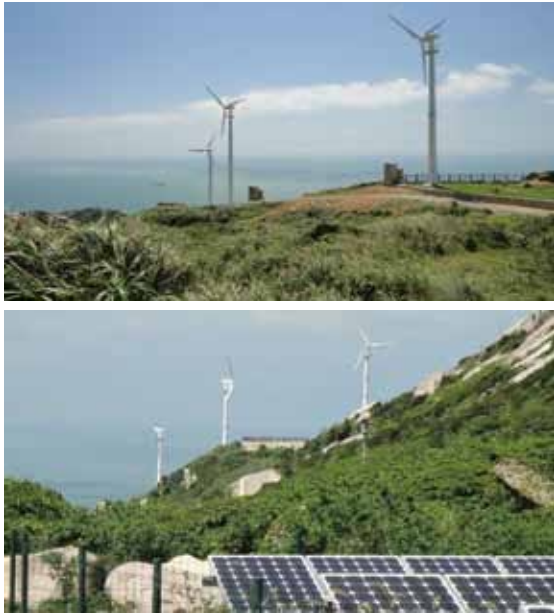
图 9: 东福山岛风光储柴微电网发电系统
