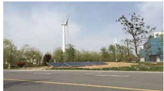
图 11: 江苏大丰商业化风光互补微电网供电系统
