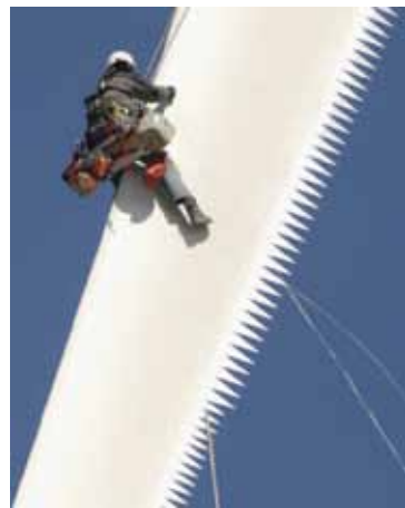
图 5: 锯齿形后缘安装在叶片上的情形
